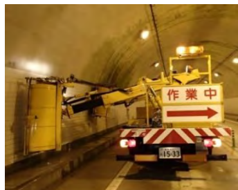
(トンネル内清掃)
