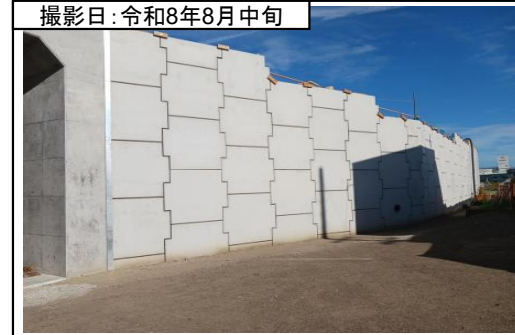
④大代ICランプ(帯鋼補強土壁)
