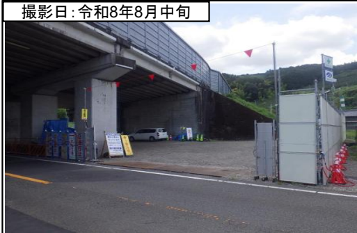
②大代IC番生寺跨道橋(下部工準備)
