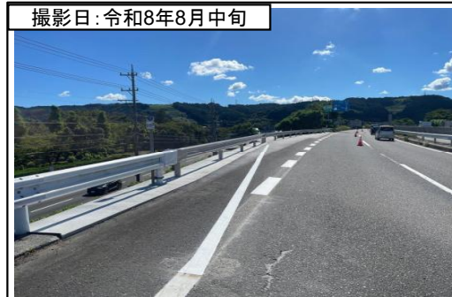
⑥大代IC下り線(非常駐車帯新設)
