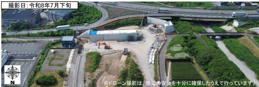
⑤大代IC Bランプ施工状況 全体写真
