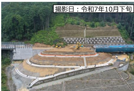
⑤ 本線盛土
