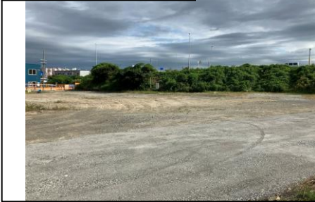
②大代IC ランプBOXカルバート施工前
