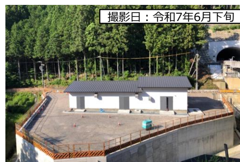
⑥ トンネル主電気室
