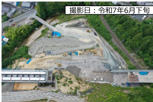
⑤ 本線盛土
