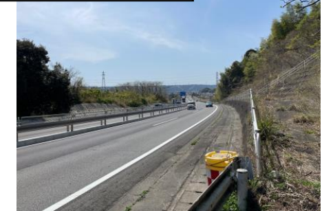
⑤伊太谷川橋
