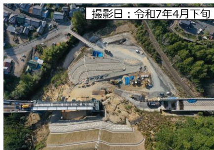
⑤ 本線盛土
