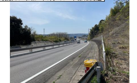
⑤伊太谷川橋
