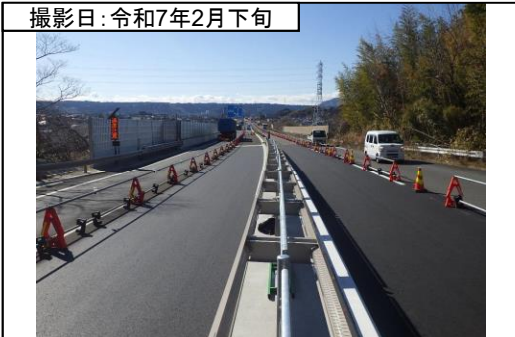
⑤伊太谷川橋
