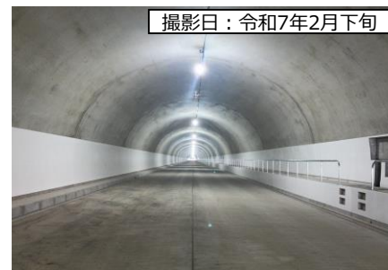
⑦4号トンネル (仮称)
