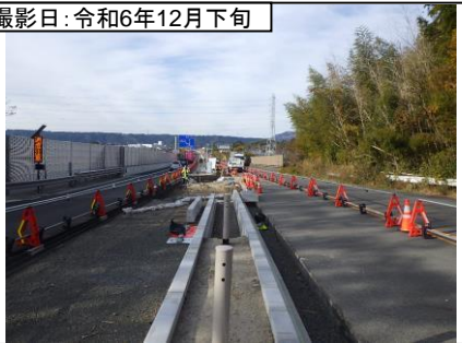
⑤伊太谷川橋
