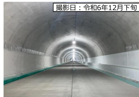
⑦4号トンネル (仮称)
