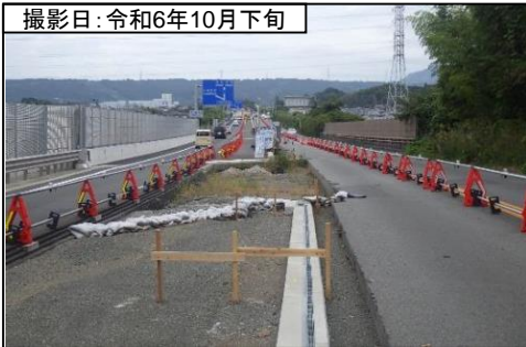
⑤伊太谷川橋
