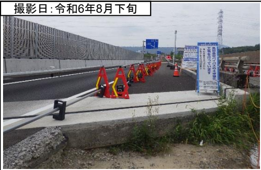
⑤伊太谷川橋
