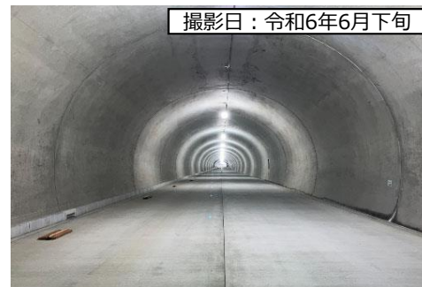
⑦ 4号トンネル (仮称)
