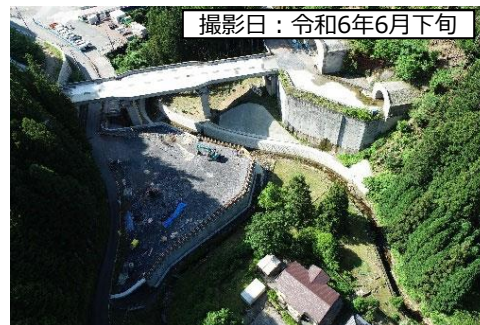
⑥トンネル主電気室
