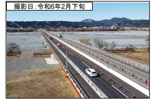
④新大井川橋
