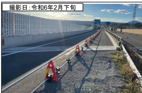
⑤伊太谷川橋
