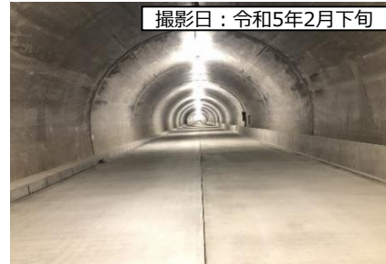
⑥3号トンネル (仮称)
