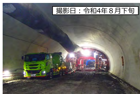
⑥4号トンネル (仮称)
