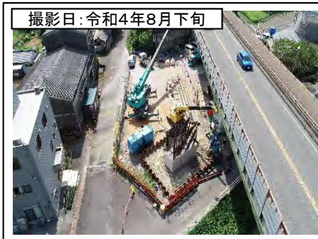
⑥伊太谷川橋(P1橋脚)
