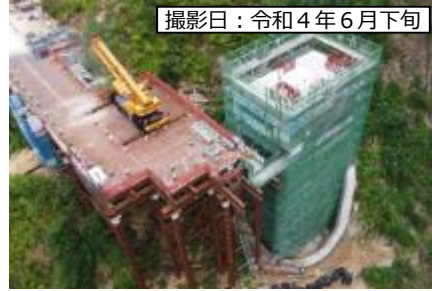
②8号橋 (仮称) P2橋脚
