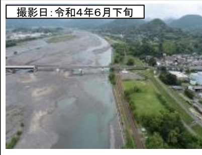
⑤新大井川橋(P9橋脚~A2橋台)
