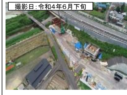
③大代IC(ランプ橋 A2橋台)
