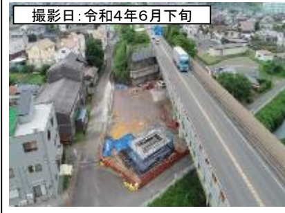
⑦伊太谷川橋(P1橋脚)
