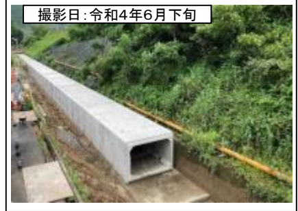
⑧野田IC(水路ボックス)
