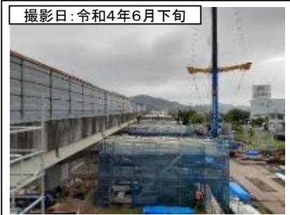
⑥島田第1高架橋(東京方面を望む)
