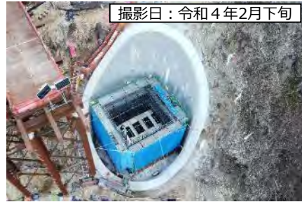
②8号橋(仮称) P2橋脚
