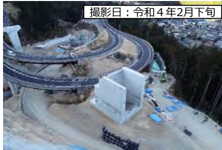
①9号橋(仮称) A2橋台
