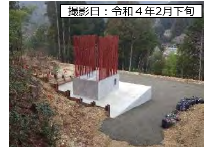
④7号橋(仮称)P1橋脚
