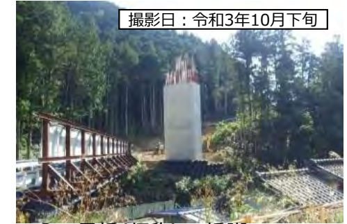
④7号橋(仮称)P2橋脚
