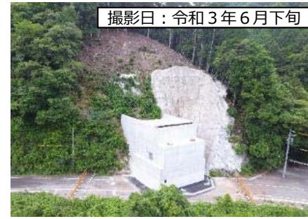
⑦1号橋(仮称) A1橋台
