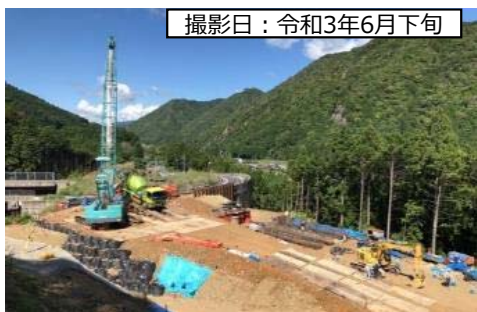
①9号橋(仮称) A2橋台
