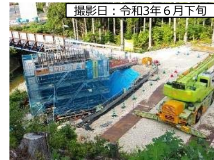
④7号橋(仮称)P2橋脚
