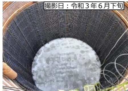
②8号橋(仮称) P1橋脚
