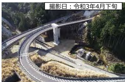
①9号橋 (仮称) P1橋脚
