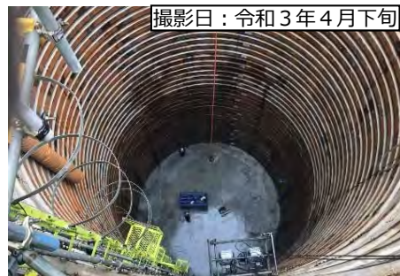
②8号橋 (仮称) P1橋脚
