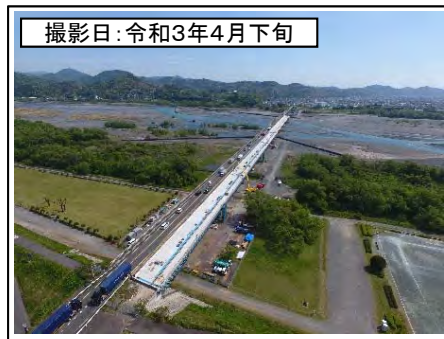
⑤新大井川橋右岸(東京方面を望む)
