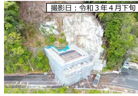
⑦1号橋 (仮称) A1橋台
