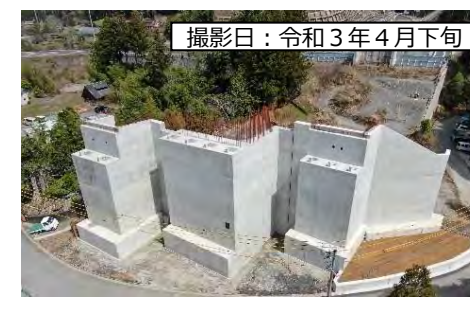
⑧1号橋 (仮称) A2橋台
