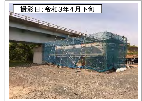
⑧新大井川橋左岸(P13橋脚)
