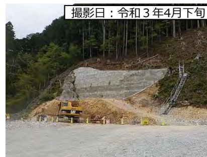
③7号橋(仮称)A1橋台
