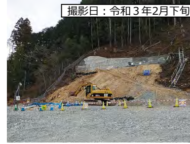
③7号橋(仮称)A1橋台
