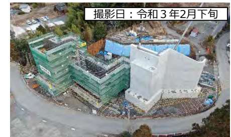
⑧1号橋(仮称) A2橋台
