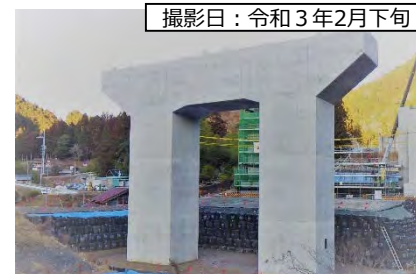
⑦1号橋(仮称) P3橋脚
