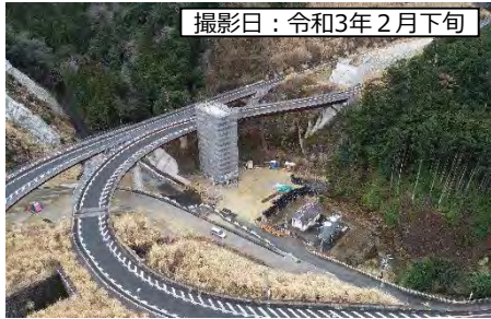
①9号橋(仮称) P1橋脚
