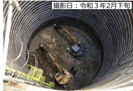
②8号橋(仮称) P1橋脚
