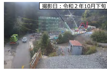
⑧ 1号橋 (仮称) A2橋台
