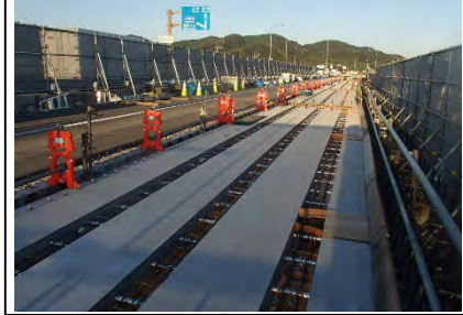
⑧ 向谷IC付近(東京方面を望む)
