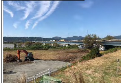
⑦ 新大井川橋左岸
