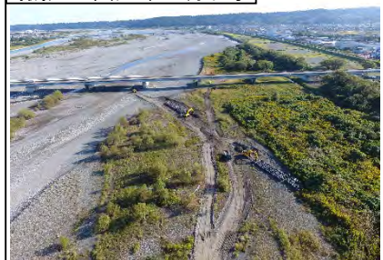
⑥ 新大井川橋右岸
