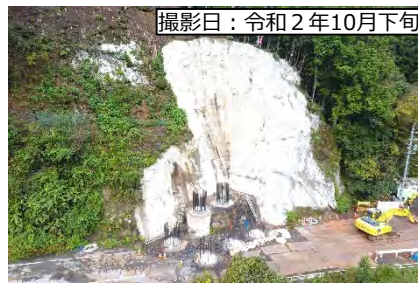
⑥ 1号橋(仮称) A1橋台
