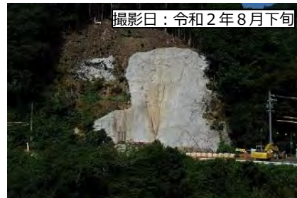
⑥ 1号橋(仮称) A1橋台
