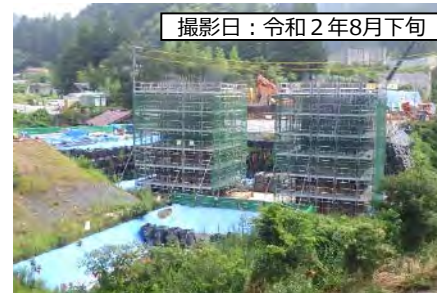
⑦ 1号橋 (仮称) P3橋脚
