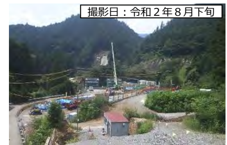
⑧ 1号橋 (仮称) A2橋台
