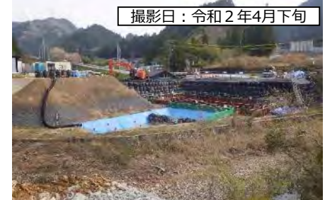
⑧ 1号橋 (仮称) P3橋脚
