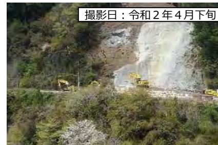
⑦ 1号橋(仮称) A1橋台
