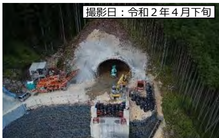
⑤ 1号トンネル(仮称) 坑口
