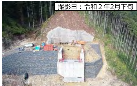
⑤ 1号トンネル(仮称) 坑口
