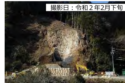
⑦ 1号橋(仮称) A1橋台
