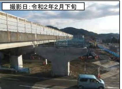
⑦向谷IC付近(東京方面を望む)
