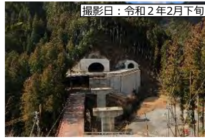
⑥ 3号トンネル(仮称) 東栄側坑口
