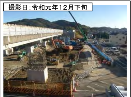
⑦向谷IC付近(東京方面を望む)
