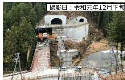
⑥ 3号トンネル(仮称) 東栄側坑口
