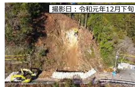
⑦ 1号橋(仮称) A1橋台
