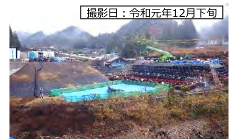
⑧ 1号橋(仮称) P3橋脚
