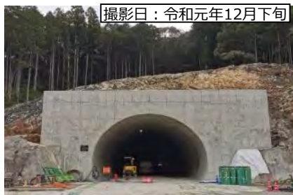
⑤ 3号トンネル(仮称) 新城側坑口
