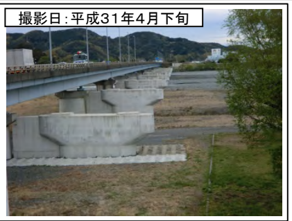
⑦新大井川橋右岸より
