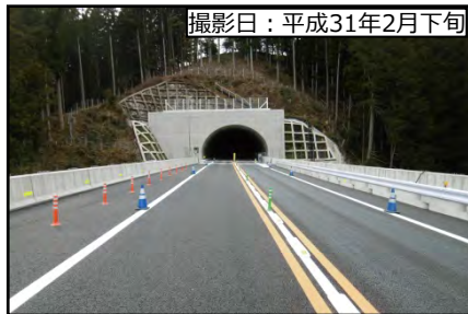
⑦川合トンネル 佐久間川合側坑口
