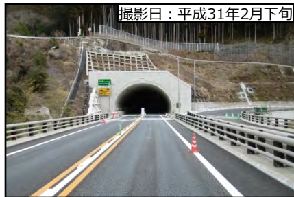
⑥川合トンネル 浦川側坑口
