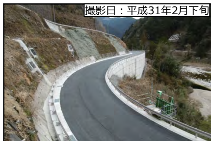
⑤浦川IC 左岸連絡路
