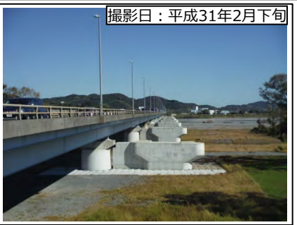
⑦新大井川橋右岸より
