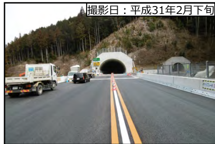
②浦川・奈根トンネル 東栄側坑口
