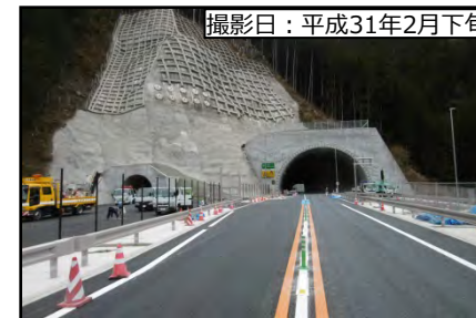
④浦川・奈根トンネル 浦川側坑口
