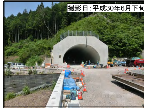
②佐久間第1トンネル(仮称)東栄側
