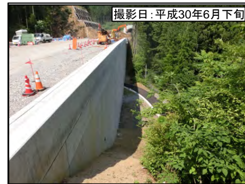
③東栄IC(仮称)BOXカルバート
