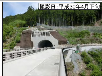
⑥佐久間第2トンネル(仮称)浦川側坑口
