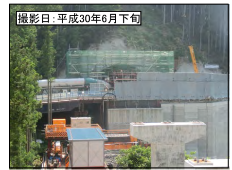
⑤ 3号トンネル東栄側
