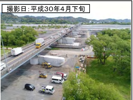
⑤ 新大井川橋右岸より
