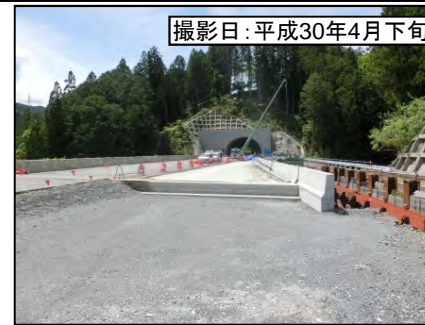
⑦佐久間第2トンネル(仮称)佐久間側坑口
