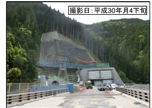
④佐久間第1トンネル(仮称)浦川側坑口
