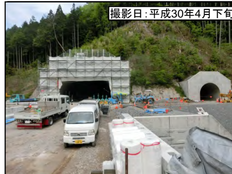
②佐久間第1トンネル(仮称)東栄側
