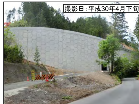
③東栄IC(仮称)BOXカルバート
