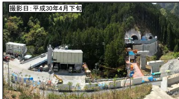
④ 3号トンネル東栄側
