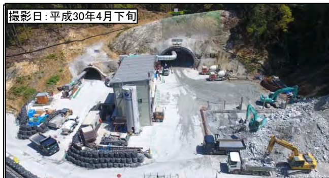
③ 3号トンネル新城側
