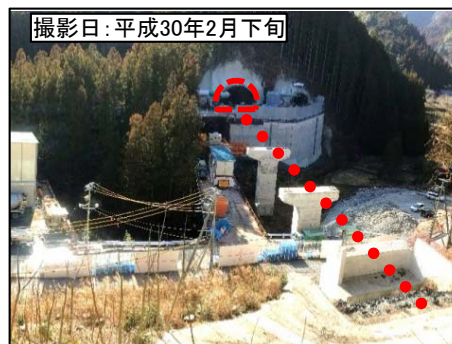
④ 3号トンネル東栄側
