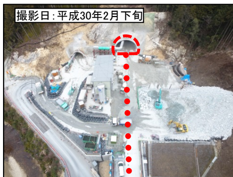
③ 3号トンネル新城側
