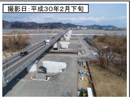
⑤ 新大井川橋右岸より
