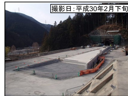
⑦佐久間第2トンネル(仮称)佐久間側坑口
