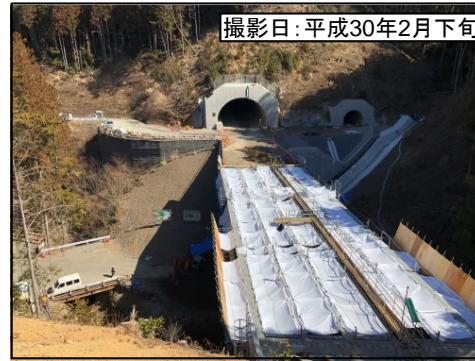
②佐久間第1トンネル(仮称)東栄側
