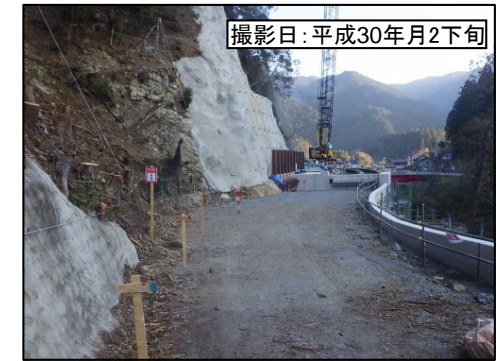
④浦川IC(仮称)左岸連絡路
