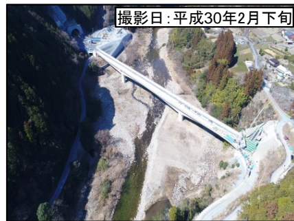
⑤大千瀬川橋(仮称)
