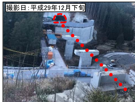
④ 3号トンネル東栄側
