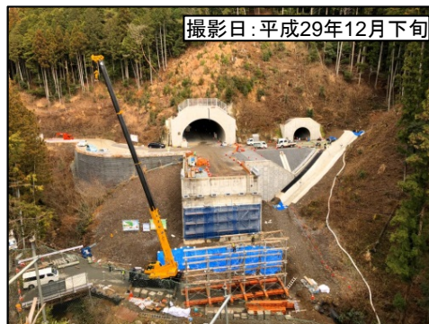
②佐久間第1トンネル(仮称)東栄側
