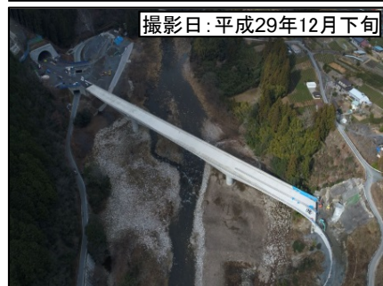
⑤大千瀬川橋(仮称)
