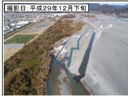
⑥ 新大井川橋下流部より
