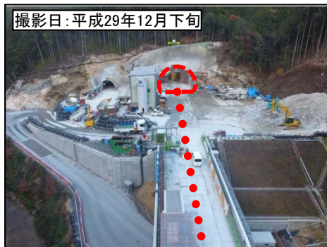
③ 3号トンネル新城側
