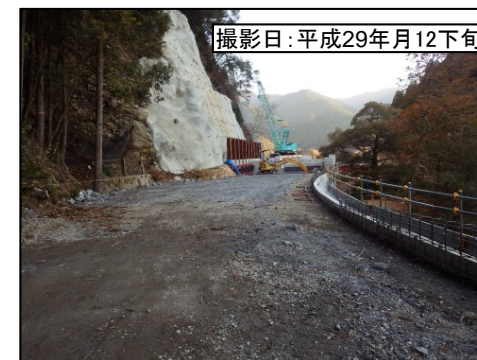
④浦川IC(仮称)左岸連絡路
