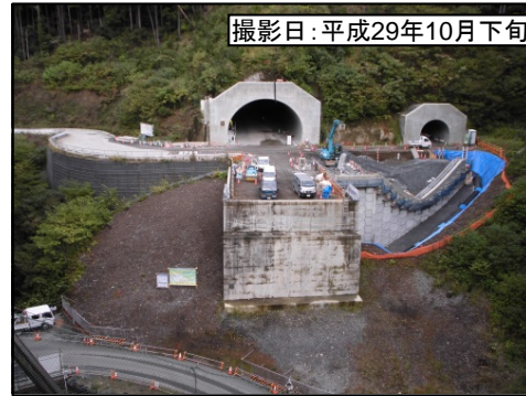
②佐久間第1トンネル(仮称)東栄側
