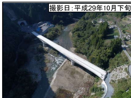
⑤大千瀬川橋(仮称)
