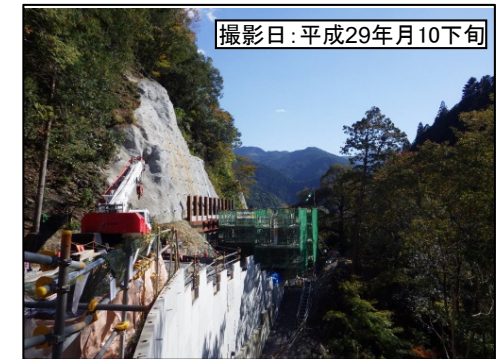
④浦川IC(仮称)左岸連絡路
