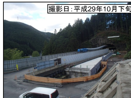
⑥佐久間第2トンネル(仮称)佐久間側坑口
