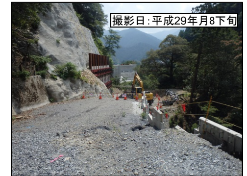
④浦川IC(仮称)左岸連絡路
