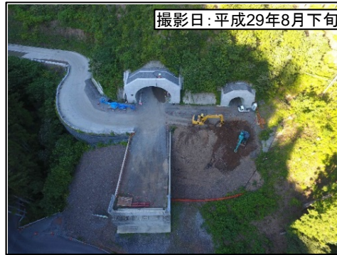
②佐久間第1トンネル(仮称)東栄側
