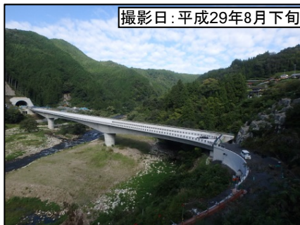
⑤大千瀬川橋(仮称)
