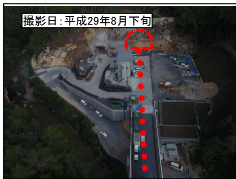
③ 3号トンネル新城側
