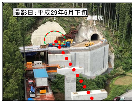
④ 3号トンネル東栄側
