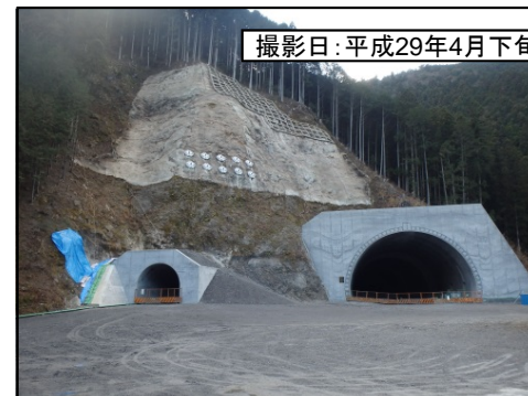
③佐久間第1トンネル(仮称)浦川側坑口
