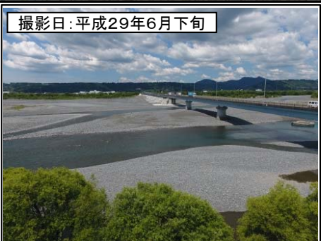
⑥新大井川橋左岸より
