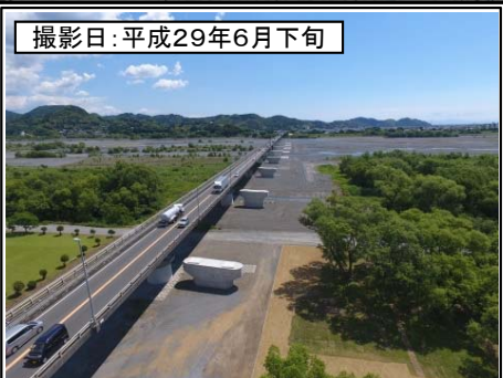
⑤新大井川橋
