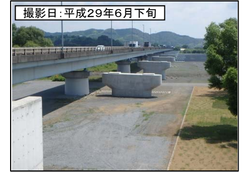
④新大井川橋右岸より
