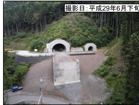
②佐久間第1トンネル(仮称)東栄側
