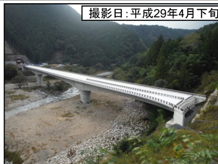
⑤大千瀬川橋(仮称)
