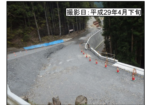
④浦川IC(仮称)左岸連絡路
