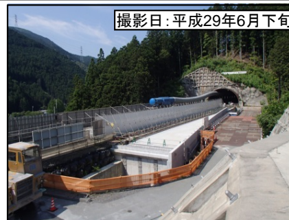
⑥佐久間第2トンネル(仮称)佐久間側坑口
