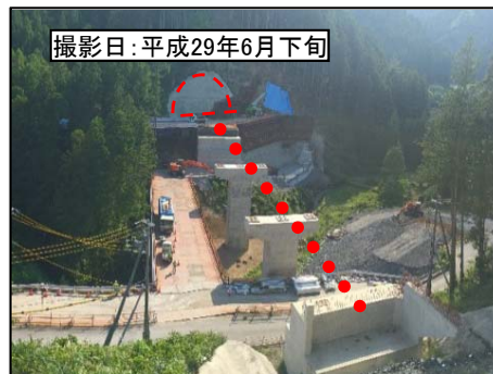
④ 3号トンネル東栄側
