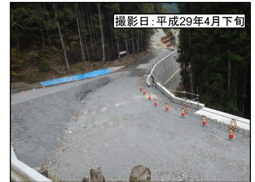
④浦川IC(仮称)左岸連絡路
