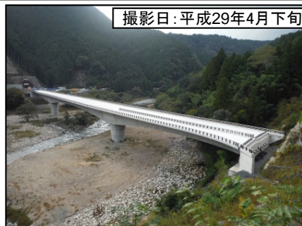
⑤大千瀬川橋(仮称)
