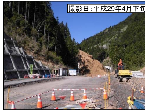
②東栄IC 佐久間第1トンネル東栄側
