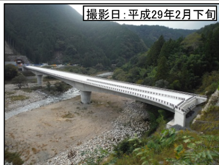
⑤大千瀬川橋(仮称)
