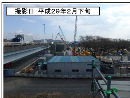
②新大井川橋右岸より
