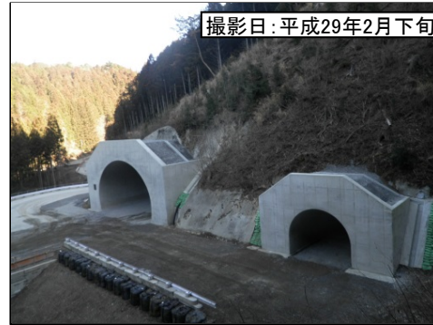
②佐久間第1トンネル(仮称) 東栄側坑口
