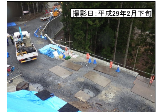
④浦川IC(仮称) 左岸連絡路
