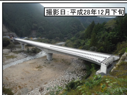
⑤大千瀬川橋(仮称)
