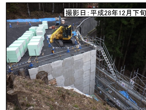
④浦川IC(仮称)左岸連絡路
