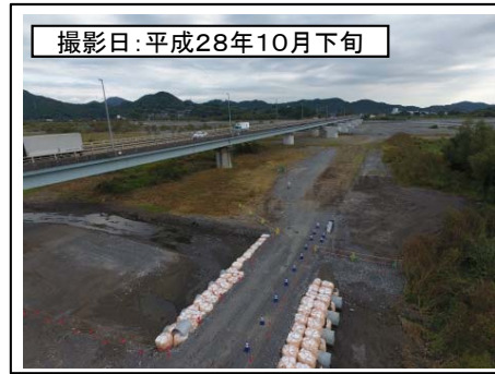
③ 新大井川橋
