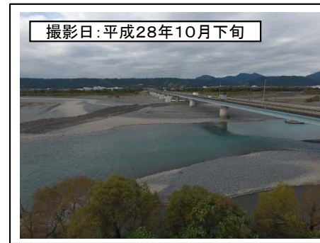
④ 新大井川橋左岸より
