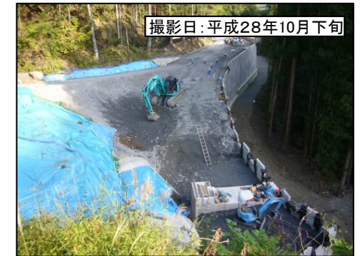
④浦川IC(仮称)左岸連絡路
