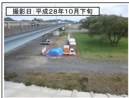
② 新大井川橋右岸より
