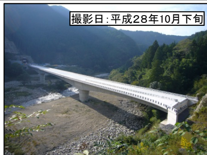
⑤大千瀬川橋(仮称)
