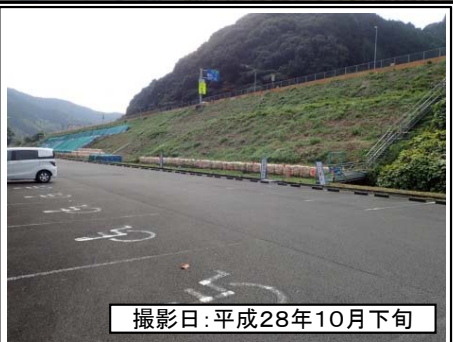
⑦ 野田IC付近 (東京方面を望む)
