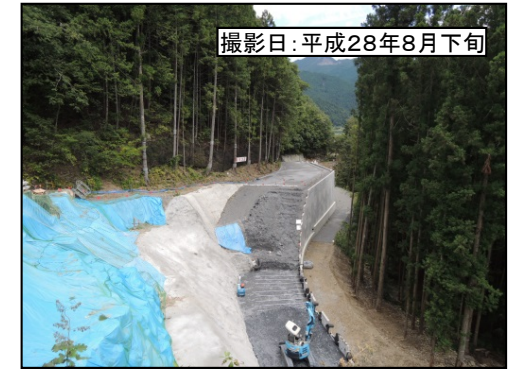
④浦川IC(仮称)左岸連絡路
