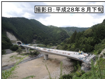
⑤大千瀬川橋(仮称)
