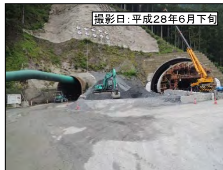
③佐久間第1トンネル(仮称)浦川側坑口
