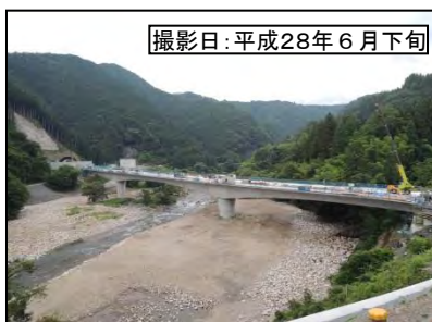
⑤大千瀬川橋(仮称)
