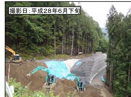
④浦川IC(仮称)左岸連絡路
