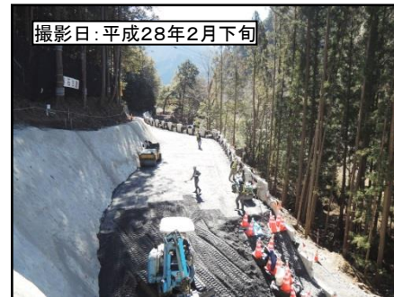
④浦川IC(仮称)左岸連絡路
