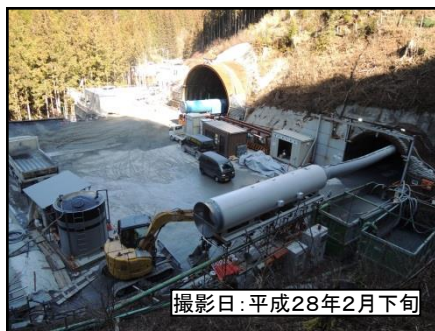
②佐久間第1トンネル(仮称)東栄側坑口
