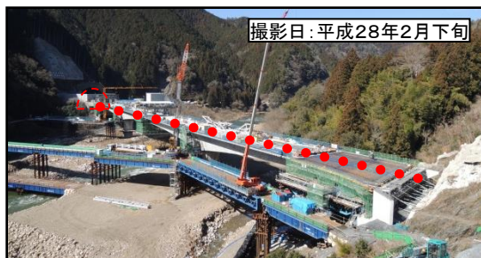
⑤大千瀬川橋(仮称)
