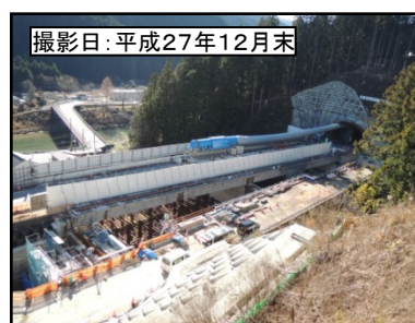
⑥佐久間第2トンネル(佐久間側坑口)
