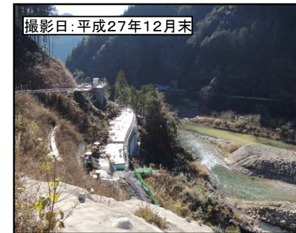
④浦川左岸連絡路
