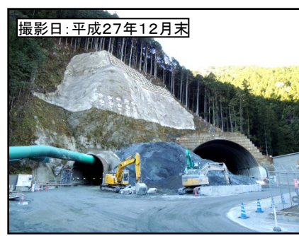
③佐久間第1トンネル(浦川側坑口)
