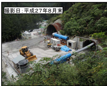
②佐久間第1トンネル(坑口)
