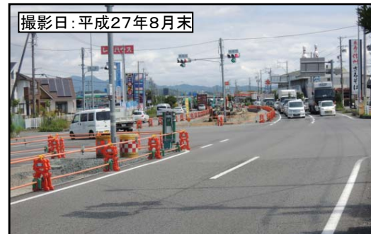
⑦梅橋交差点付近
