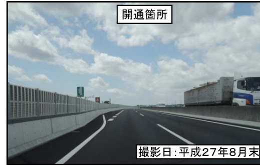
③国本高架橋(上り線)
