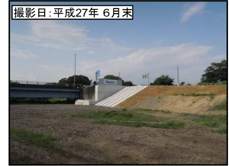
③新大井川橋
