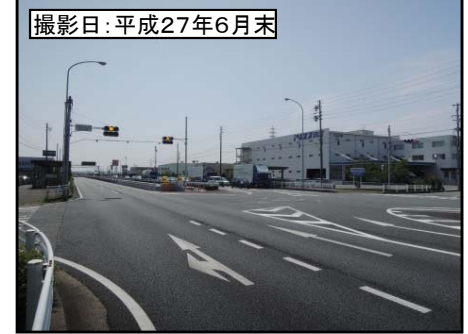
⑧不入斗入口交差点付近
