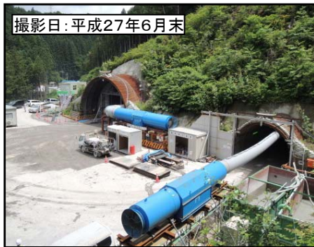
②佐久間第1トンネル(坑口)
