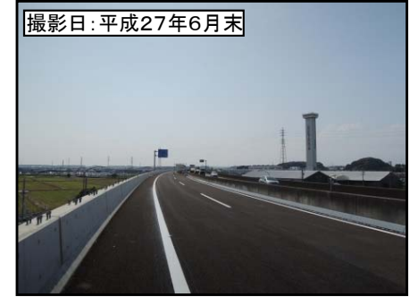
④沖之川高架橋
