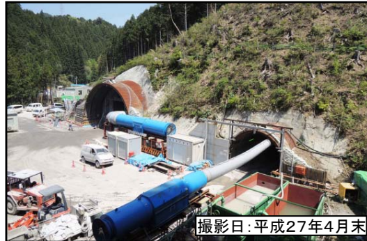
②佐久間第1トンネル(坑口)
