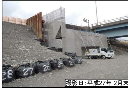
②新大井川橋
