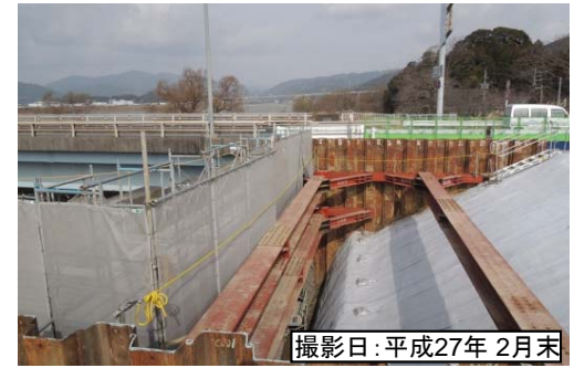
③新大井川橋
