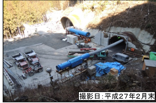
②佐久間第1トンネル(坑口)
