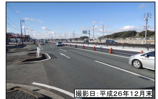
⑧国本地下道付近
