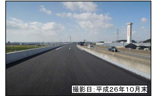
④沖之川高架橋
