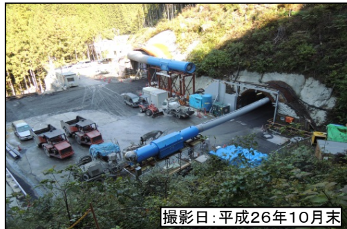
②佐久間第1トンネル(坑口)
