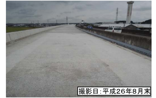
④沖之川高架橋
