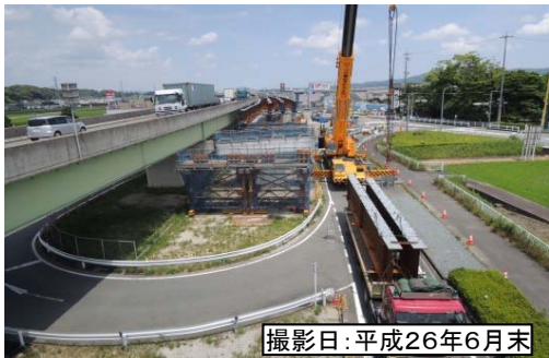
⑤国本高架橋
