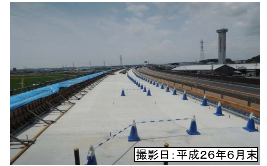
④沖之川高架橋
